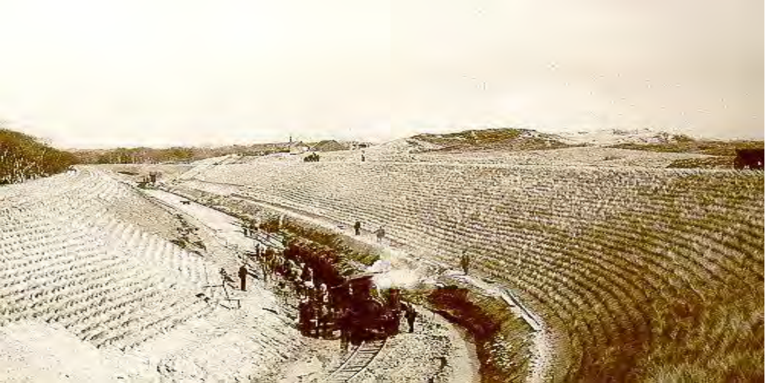
Aanleg winkanalen in de duinen 1850-1870.
